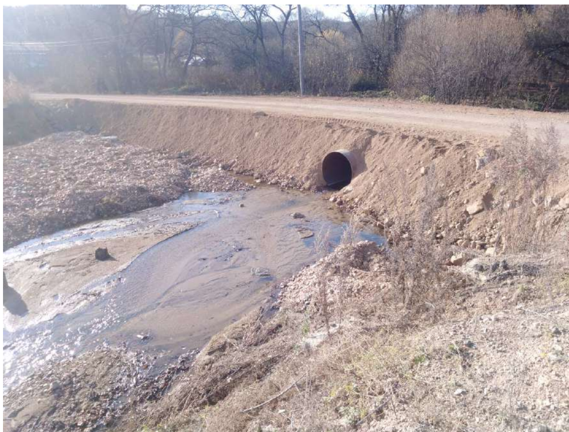
Фото 4. Нижний бьеф обновленной насыпи объезда с водопропускной трубой. Вид с левобережного подхода смытого моста вверх по течению (лето 2020 г).
